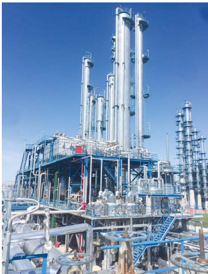
На фото: Установка изомеризации n-бутана по технологии «Изомалк-3» компании Liaoning Hualu Specialty Asphalt Co, (провинция Ляонин, КНР).
