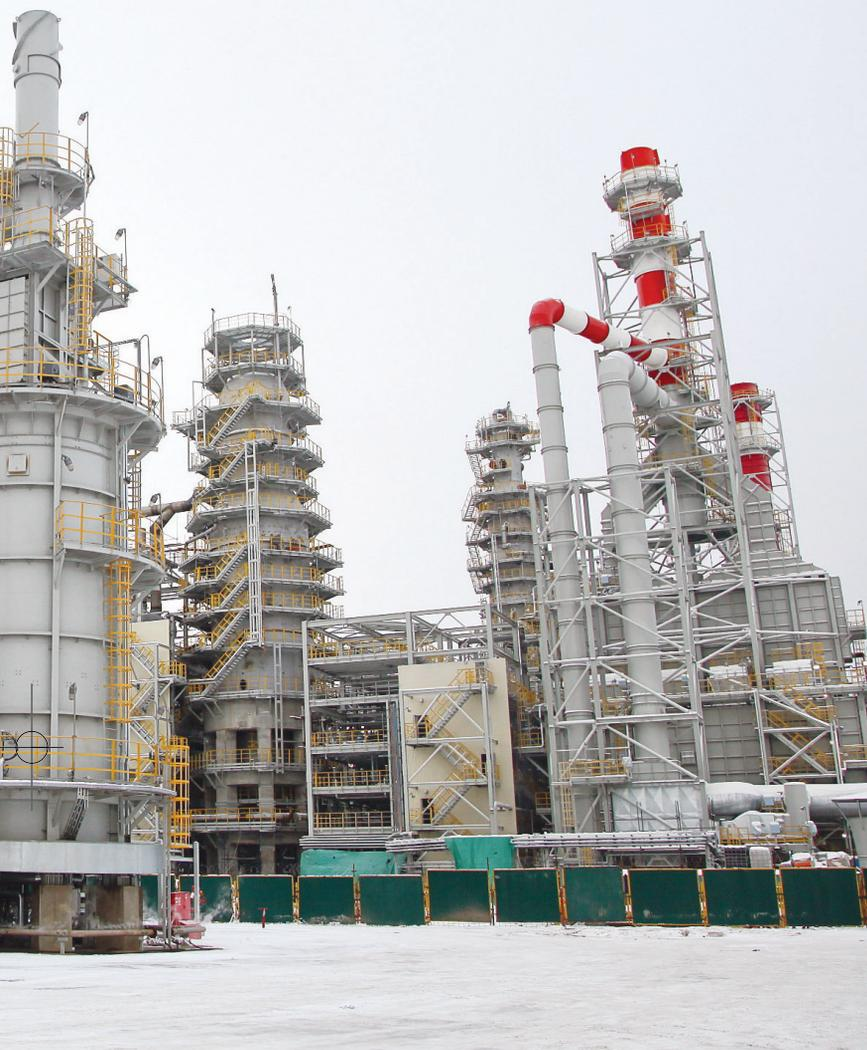
**В 2018 году Нижнекамский нефтеперерабатывающий комплекс «ТАНЕКО» ввел в эксплуатацию комплекс переработки бензиновой фракции, включающий в своем составе установку изомеризации по технологии «Изомалк-2» мощностью 420 тыс. т/год.**
